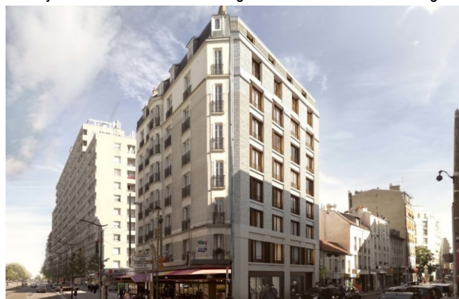
Figure 20 : Résidence Rue du Poteau – Paris (75) - Effinergie+ - MO : Immobilière 3F – Architecte : Atelier Martel
