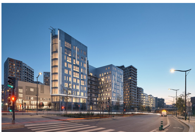
Figure 22 : Chapelle International - Itswell Kara - Paris (75) - Effinergie+ - MO : Linkcity Ile de France – Architecte : Metra & Associés
