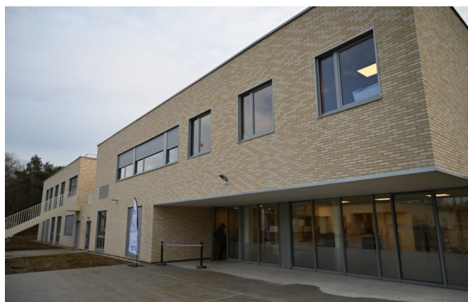
Figure 15 : Foyer Bois Verlande – Bepos Effinergie 2013 – Evreux (27) – MO : Département de l'Eure – Architectes : Babel Architectes
