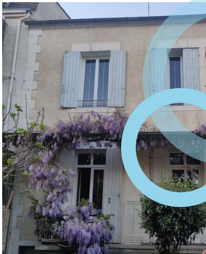
Figure 33 : Rénovation Basse Consommation et Bas Carbone - Bergerac (24) – BE : AGI-H
