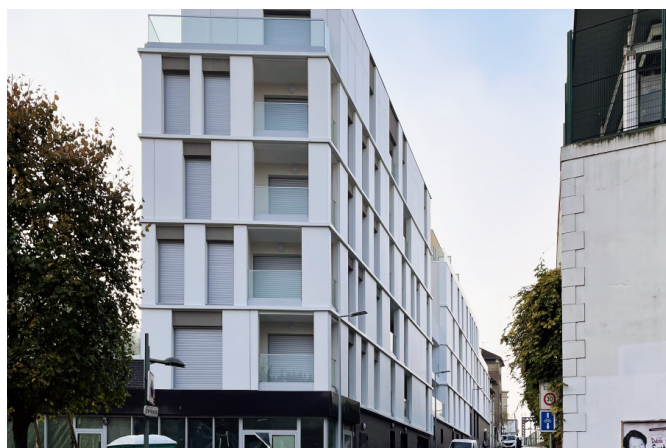
Figure 18 : Résidence Eugène Fournière - Effinergie+ - MO : Opaly – Arcueil (94) – AEC Architecture
