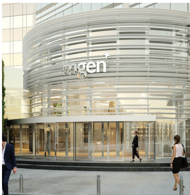
Figure 34 : Rénovation Bureaux MGEN – Paris (75) – Basse Consommation et Bas Carbone - MO : MGEN - SCI Philgen – Architecte : Quadri Fiore
