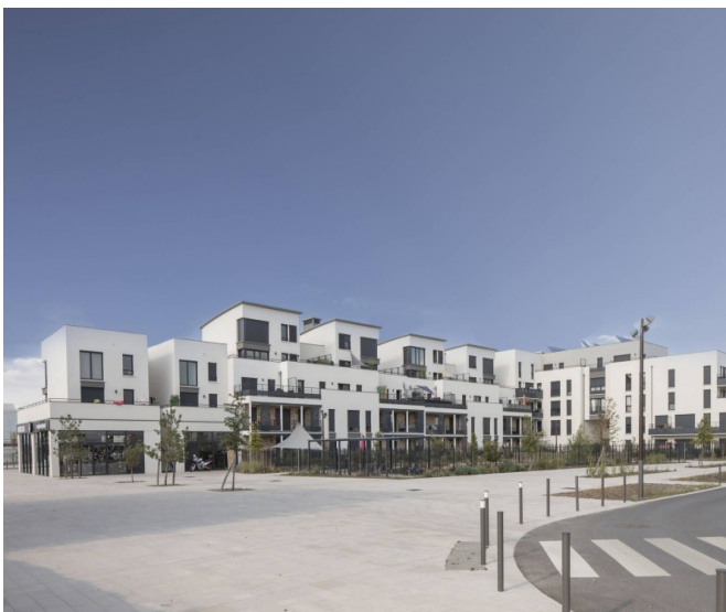
Figure 12 : Résidence G10 – Bepos Effinergie 2013 – Montreuil (77) – MO : Nexity Grand Paris – Architecte : Fourcas Architecte
