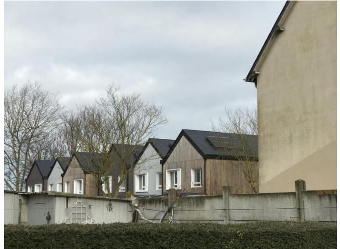
Figure 4 : Les Jardins de la Louisiane – Saint Malo (35) – BBC Effinergie 2017 – MO : Emeraude Habitation
