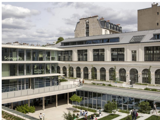
Figure 25 : Sciences PO - Paris (75) - Effinergie+ - MO : Sogelym Dixence – Architecte : Wilmotte et Associés Architectes
