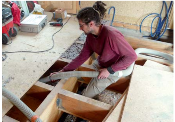
Pose de ouate de cellulose sous plancher.
