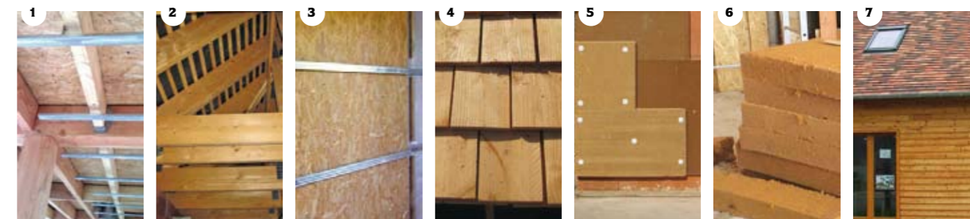
1. Ossature bois - 2. Charpente - 3. Panneaux OSB - 4. Tuile de bois - 5. Isolant : panneaux de fibre de bois (rigide) - 6. Isolant : laine de bois (souple) - 7. Bardage
