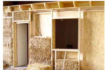
41 Maison ossature bois isolée en paille – crédit photo www.naturel-home.fr
