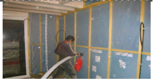
29 Insufflation de ouate de cellulose- crédit photo www.construction-naturelle.com
