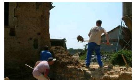
59 Démarrage d'un mur en bauge- crédit photo 'La terre crue en Basse-Normandie'
