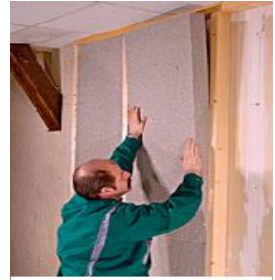
32 Pose de panneaux de ouate de cellulose
