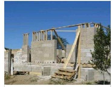
8 Construction en blocs de chanvre – Source www.batiproduit.com
