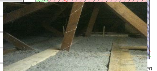
95 Combles isolés par flochage en ouate de cellulose - crédit photo
