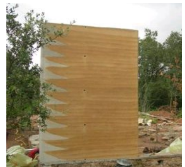
69 Mur en pisé stabilisé - crédit photo www.asterre.org
