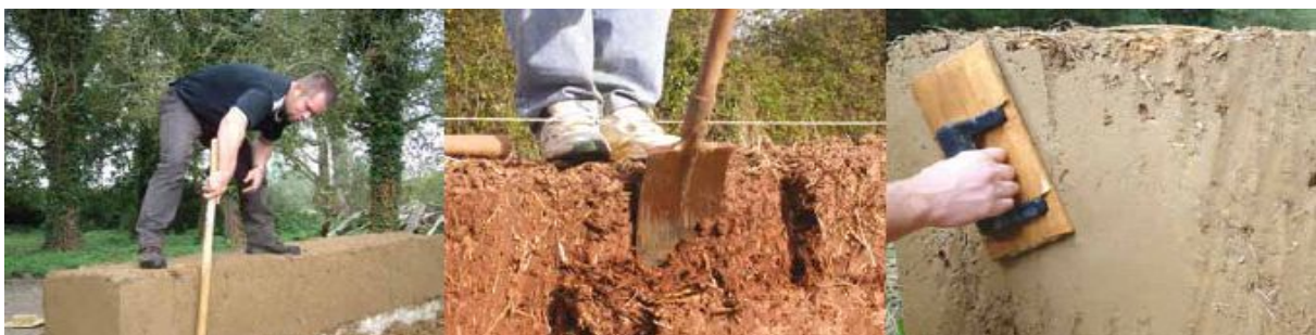
62 Compactage au bâton
