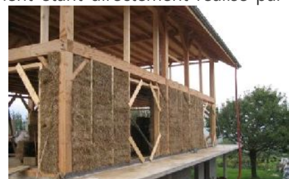
42 Maisons poteaux-poutres isolées en paille - crédit photo www.prioriterre.org
