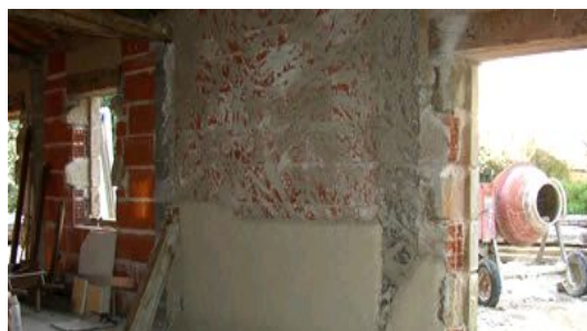
91 Crédit photo Rénovation énergétique d'un bâtiment ancien grâce à l'application d'un enduit chaux-chanvre - www.isolation-chanvre-vendee.com
