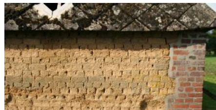
76 Angle de mur et soubassement en briques de terre cuite, Thiberville (27) - source F. Streiff
