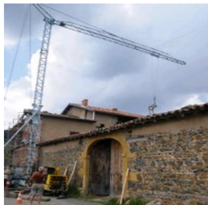
65 Utilisation d'une grue pour une construction en pisé - crédit photo www.lafermeeverdy.com
