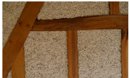
6 Béton de chanvre dans un colombage
