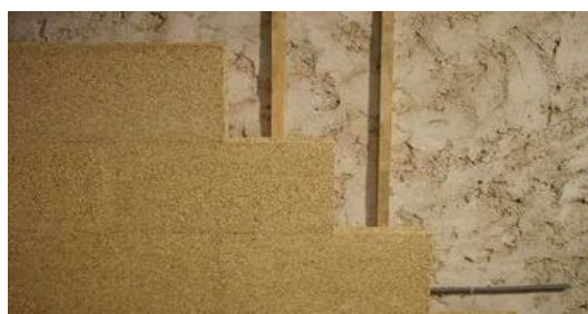
92 Doublage isolant d'un mur en terre à l'aide de blocs de chanvre -Crédit photo http://terrativ.blogspot.com
