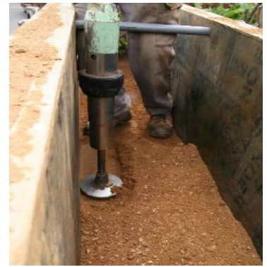
68 Damage du pisé avec un psoir pneumatique - source F. Streiff
