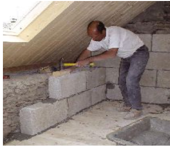
9 Pose de blocs de chanvre en ITI – crédit photo : www.cest-tout-vert.com
