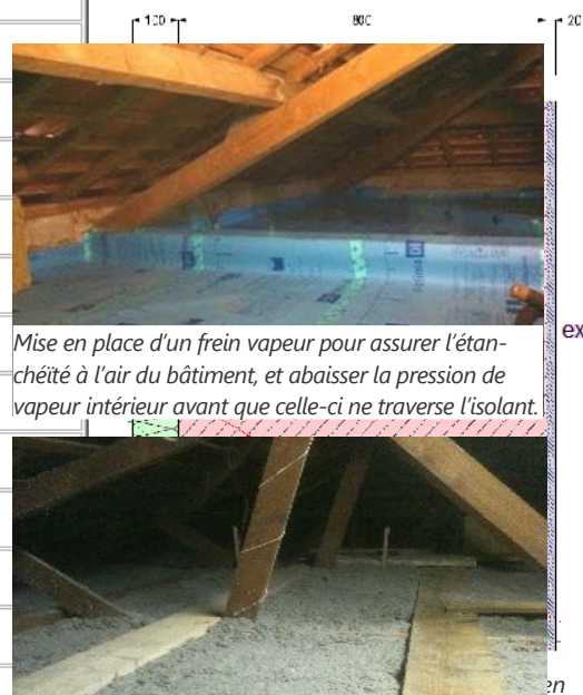
95 Combles isolés par flochage en ouate de cellulose - crédit photo
