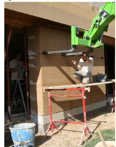
70 Mise en place d'un bloc de pisé préfabriqué, source F. Streiff
