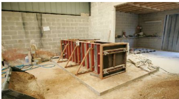
71 Coffrage de préfabrication, source F. Streiff
