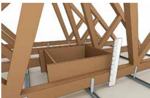
11 Pige graduée pour vérifier la hauteur d'isolat – Source www.actis-isolation.com
