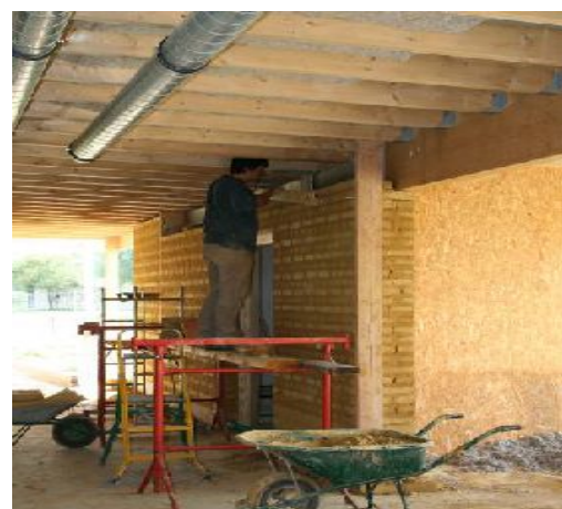
77 cloison en adobe de la maison du PNR des Marais du cotentin et du Bessin, source F. Streiff
