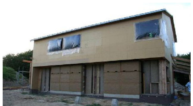
72 Murs en pisé préfabriqués, source F. Streiff
