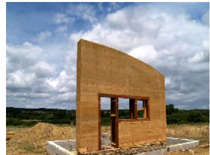
67 Mur en pisé levé – crédit photo http://storage.canalblog.com
