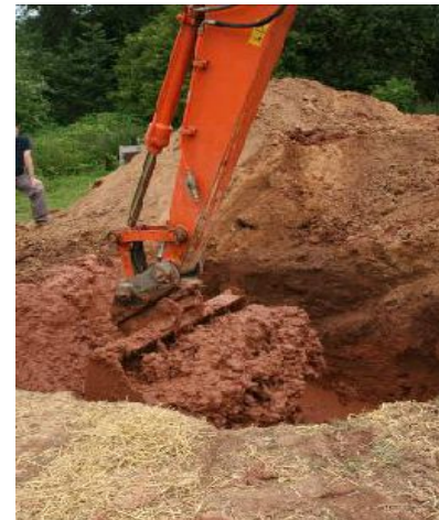
61 Préparation de la bauge à la pelleteuse
