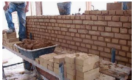
75 Montage d'un mur en briques de terre crue – crédit photo www.cd2e.com
