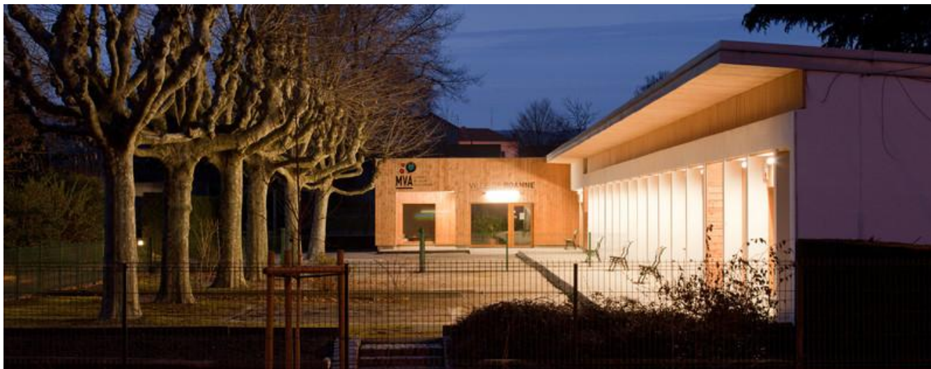
Figure 101 : Rénovation BBC – Maisons des Associations - Roanne
