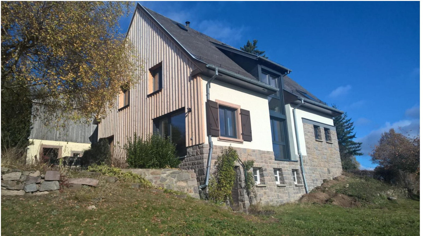
Figure 86 : Rénovation BBC – Commune de Labaroche (68910)
