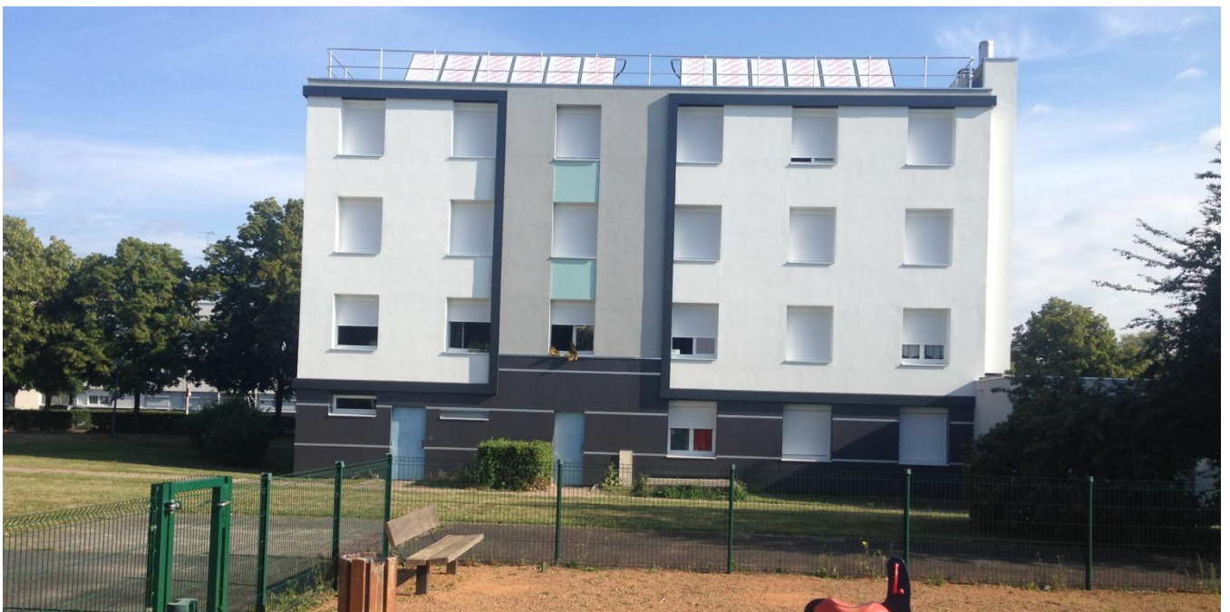
Figure 97 : Rénovation BBC – Le Grenouillet – Auvergne Habitat
