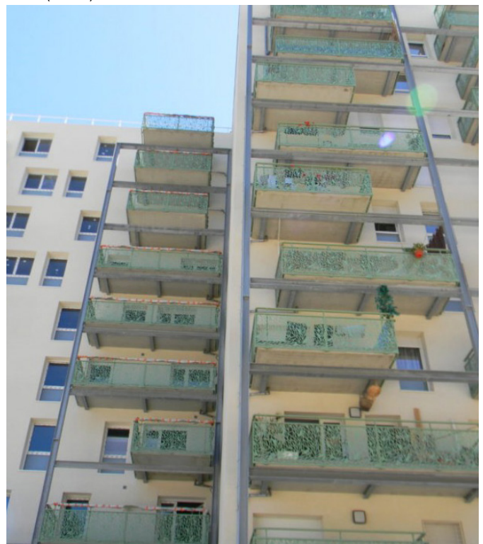
Figure 3 : Rénovation résidence la petite savine - Architecte : Soisick Cleret Architecte
