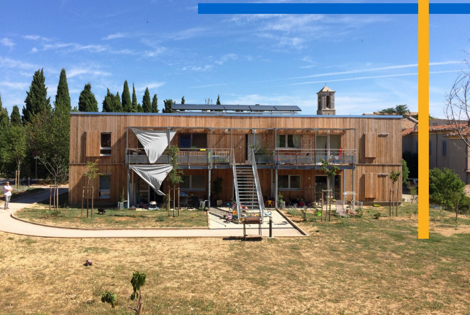
Figure 55 : Rénovation Résidence Micocoulier – Logirem - Marseille (13)
