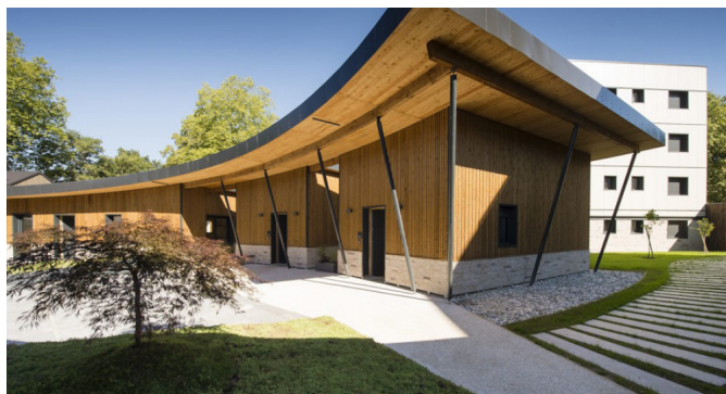
Projet intergénérationnel La Verderie | Bepos Effinergie 2013 MO : SCI La Verderie | Agence d'architecture Despagnet Pouyau - Lons
