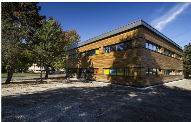
Opération Cadéra 2 | BBC-Effinergie rénovation | MO : Groupe Carle - Art'Ur Architectes | Mérignac
