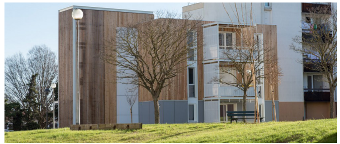
Extension Résidence Parme | Effinergie+
