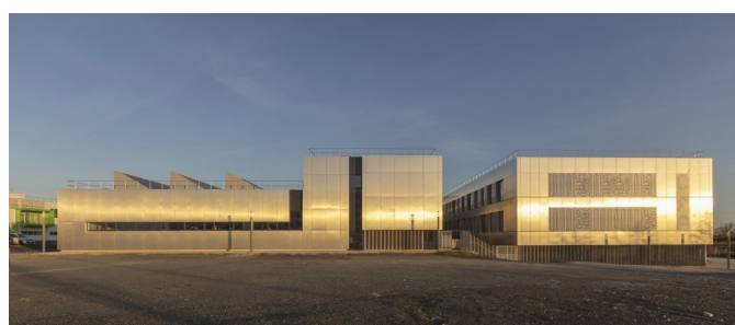
CFA de Lagord | Bepos-Effinergie 201 Photo : @Sébastien LAVA | Architecte : Agence Duclos Riboulot Kester Architectes et Créa'ture architectes | Lagord
