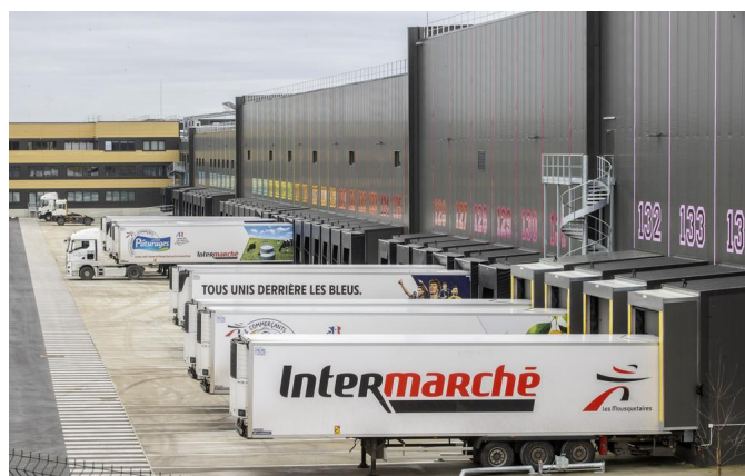
Bureaux - Base logistique Intermarché | Effinergie+ | MO : ITM Entreprises Rouillet Saint Estèphe
