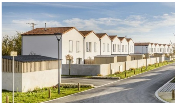
Zac Fief des Dompierres | Effinergie+ | MO : Atlantic Aménagement Triade Niort – Saint Xandre
