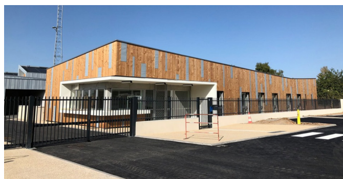
Caserne Gendarmerie | Bepos Effinergie 2013 MO : Communauté de Communes du Haut Poitou Corset Roche & Associés | Vouillé
