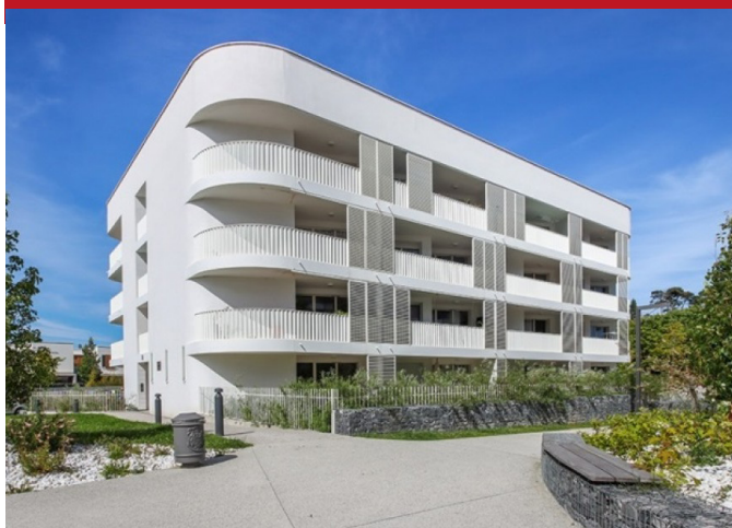
Résidence Le Carriz | Effinergie+
