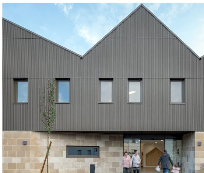
Crèche du Clos Chassaing | Bepos Effinergie 2013 MO : Le Grand Périgueux, Communauté d'agglomération TWO Architectes – Périgueux
