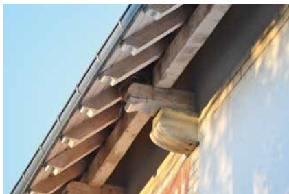
▲ Surplomb de toiture
