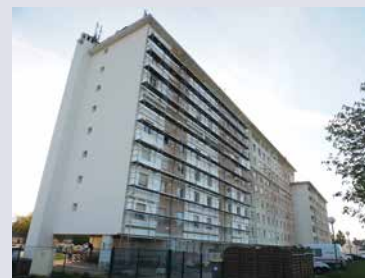
▲ Immeuble avant rénovation
